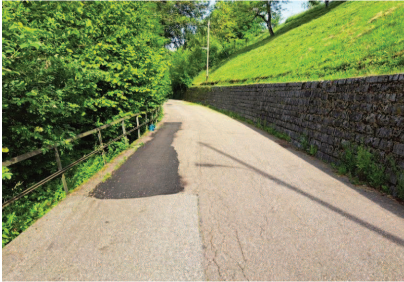
Figura 2 – Dettaglio cedimento
